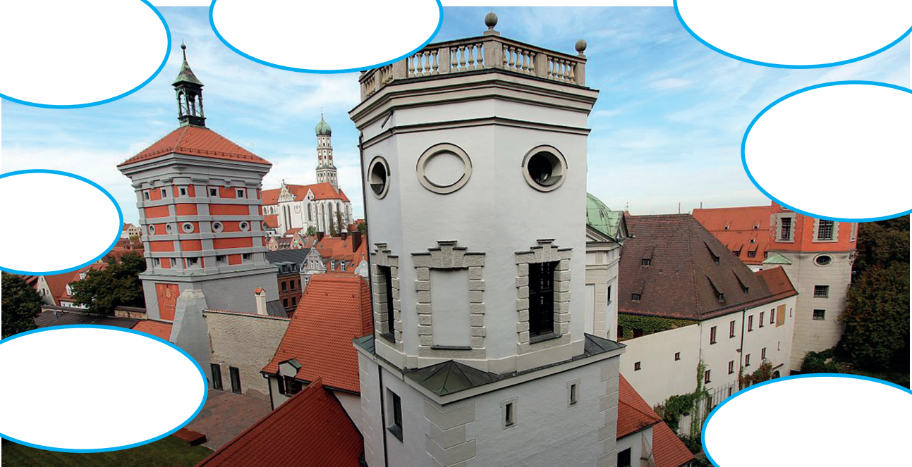
Abb. 1 Wassertürme am Roten Tor
