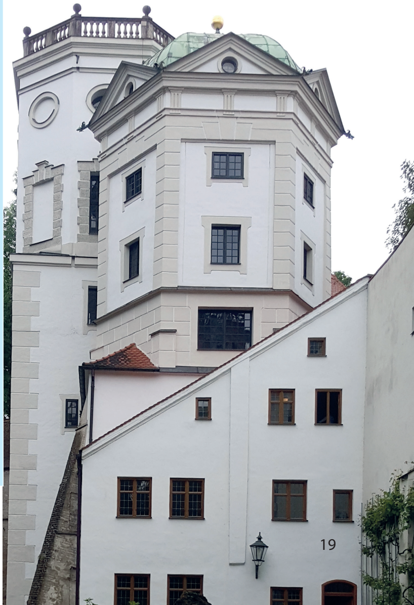
Abb.1 Wasserturm mit Brunnenmeisterhaus
